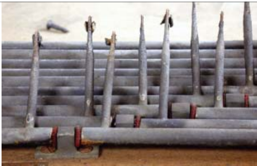
Rodetes de la reducción antes de ser restaurados
