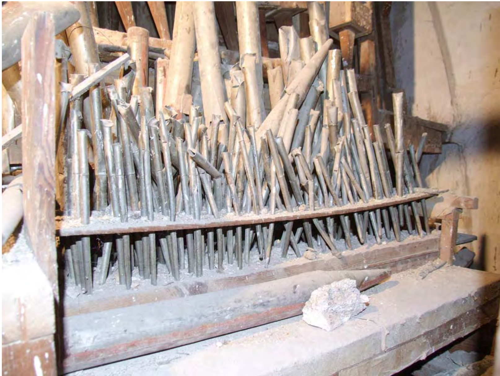
Vista de la tubería antes de la restauración
