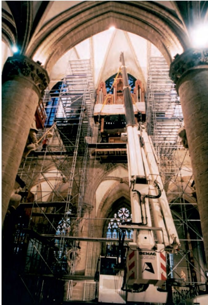
Fig. 16 Elevació dels cossos de l'orgue de la catedral de Brussel·les amb una grua. (Fotografia: Guy Lambrecht)
